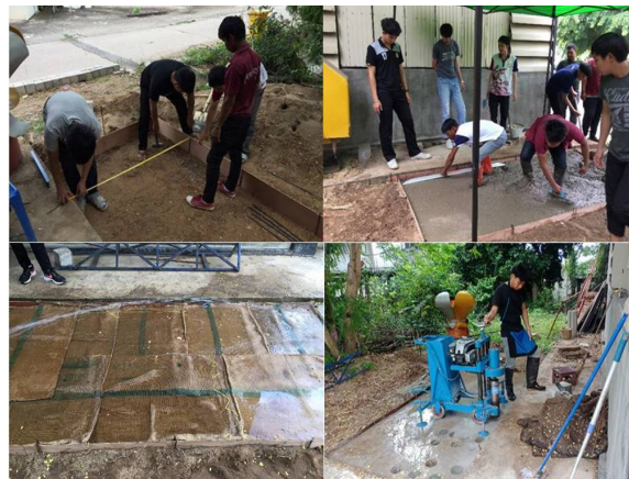
รูปที่ 1 โครงสร้างแผ่นพื้นที่ใช้ในการทดสอบ
